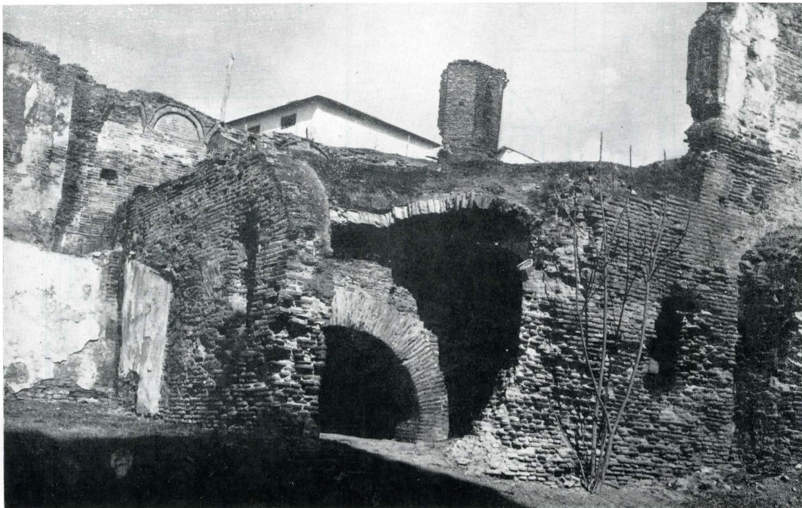
Fig. 10. Ruina caselor egumenești, văzută dinspre est. Situația din 1957.
